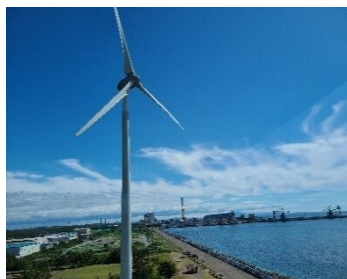
初めて見た風力発電の風車 （能代市はまなす展望台より）
